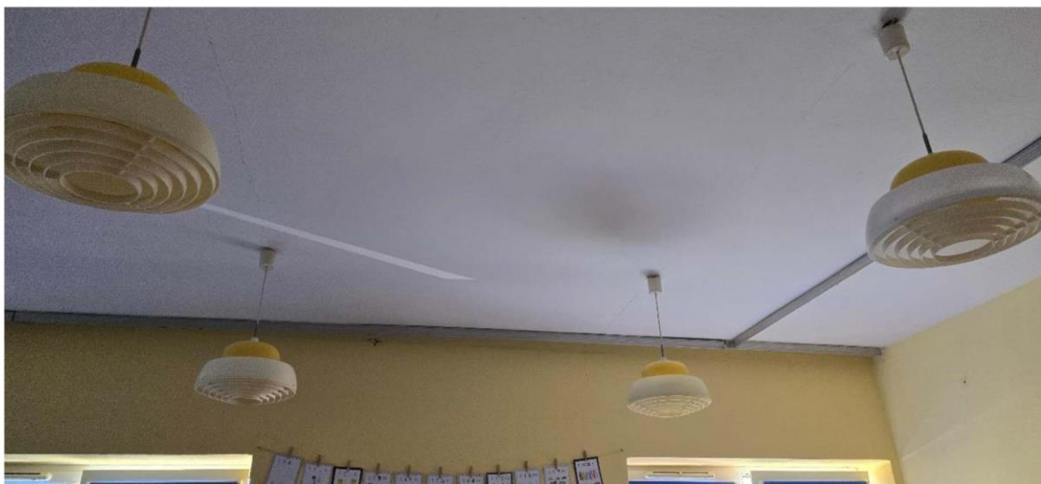
Fot 05. Widoczne zarysowania na połączeniach płyt prefabrykowanych.
