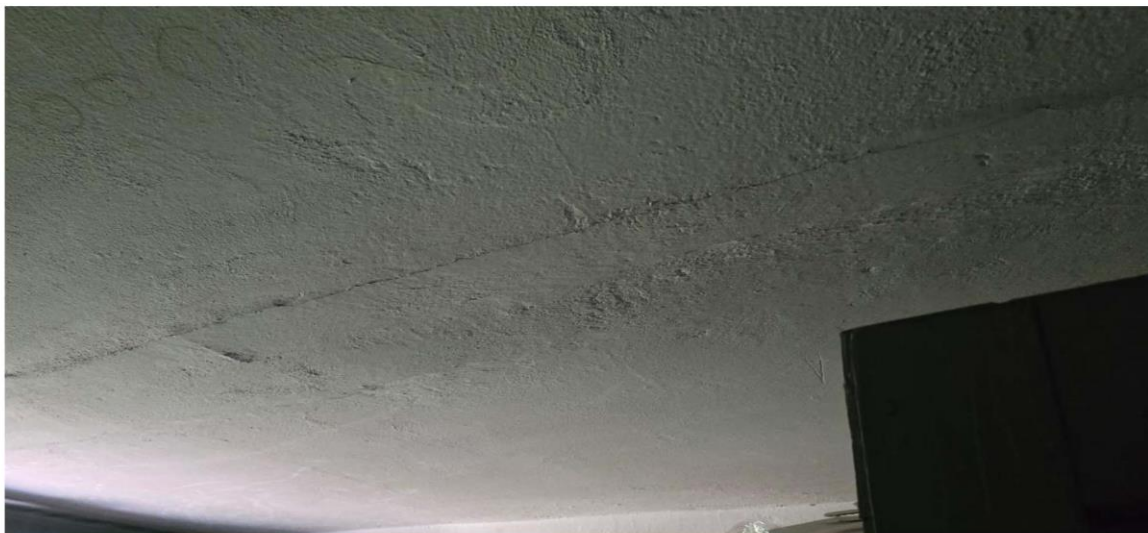
Fot 06. Widoczne zarysowania na połączeniach płyt prefabrykowanych w piwnicy.
