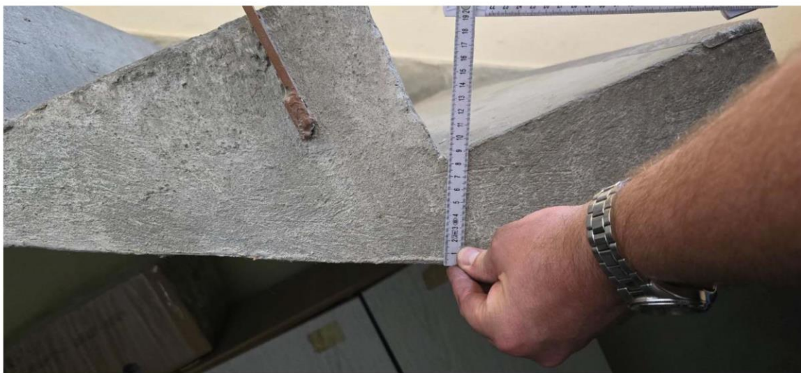
Fot 07. Grubość schodów do piwnicy.
